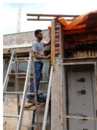
Cobertura do transformador do aparelho de RX
