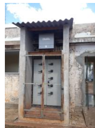
Cobertura do transformador do aparelho de RX
