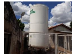
Acompanhamento da troca do tanque de oxigenio
